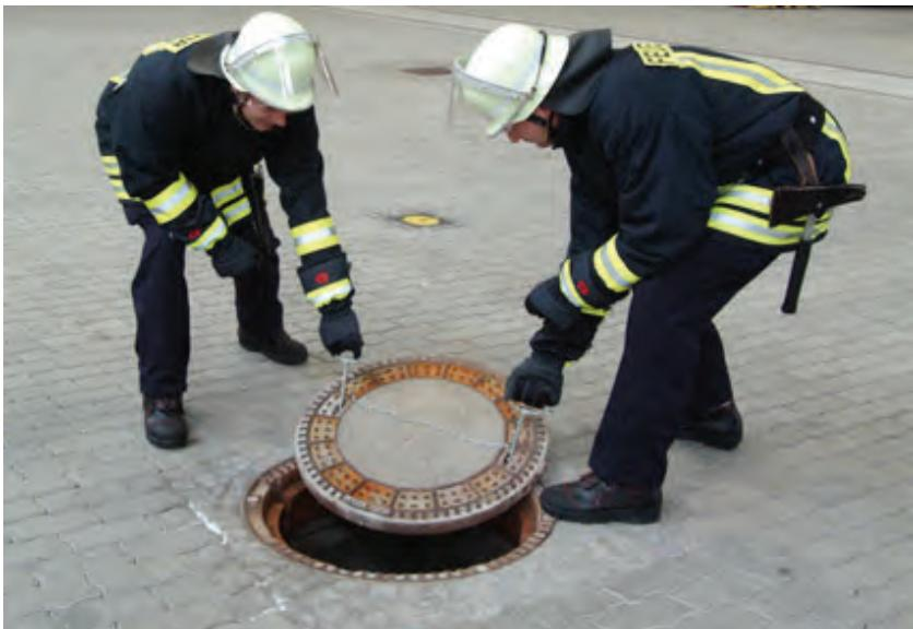
Der Schachtdeckel ist mit Hilfe der Schachthaken einseitig anzuheben und nach hinten wegzuziehen.
