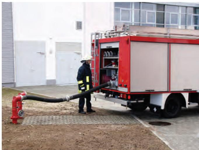
Die Entnahme aus einem Löschwasser-Sauganschluss bei Löschwasserbrunnen, -behältern und -teichen erfolgt unter Verwendung von Saugschläuchen.
