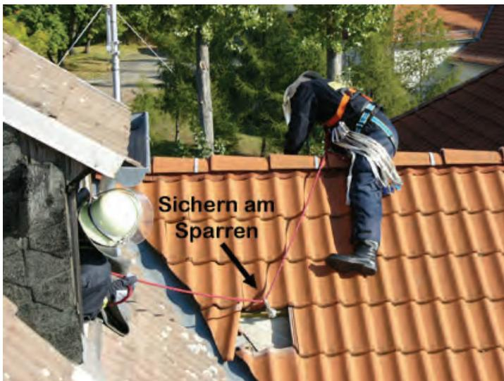
Halbmastwurf-Sicherung im Gebäude
