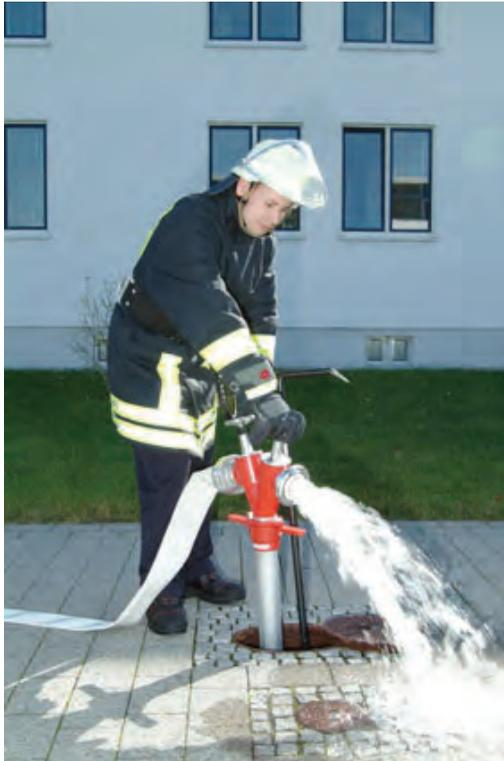
Ein Abgang am Standrohr wird geöffnet.
